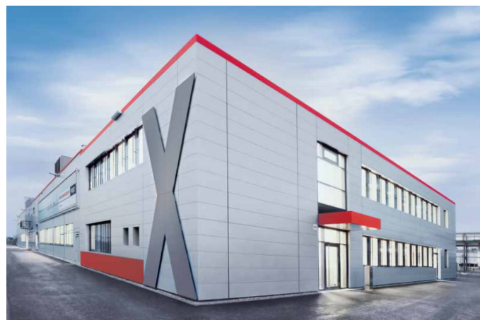
■ LANXESS produziert Lewabrane®-Membranelemente in einer hochmodernen, vollautomatisierten Anlage in Bitterfeld (Deutschland)
